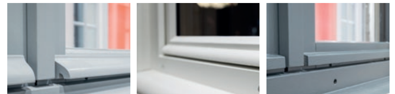
Jet d'eau à doucine
